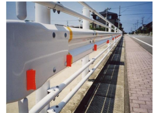
ガードレール
