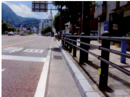
ガードパイプ
