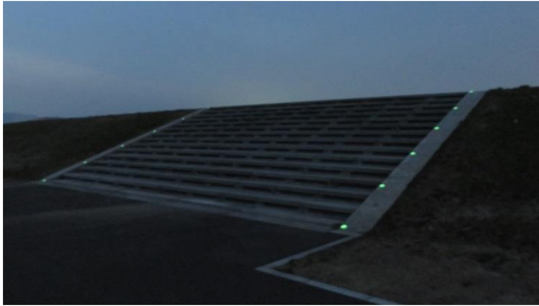
施工例 堤防階段
