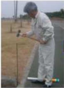
<鉄筋打ち込み>
